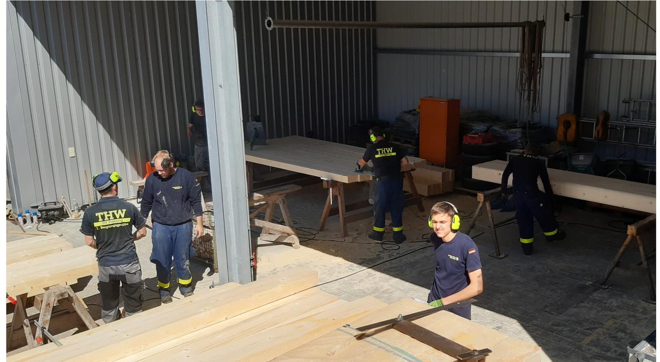
Holzbearbeitungsplatz: Die Bohlen müssen abgelängt und beidseitig mit Ausklinkungen versehen werden. Die Schramborde mit je 4 Tiefbohrungen zur Aufnahme der Schrauben
