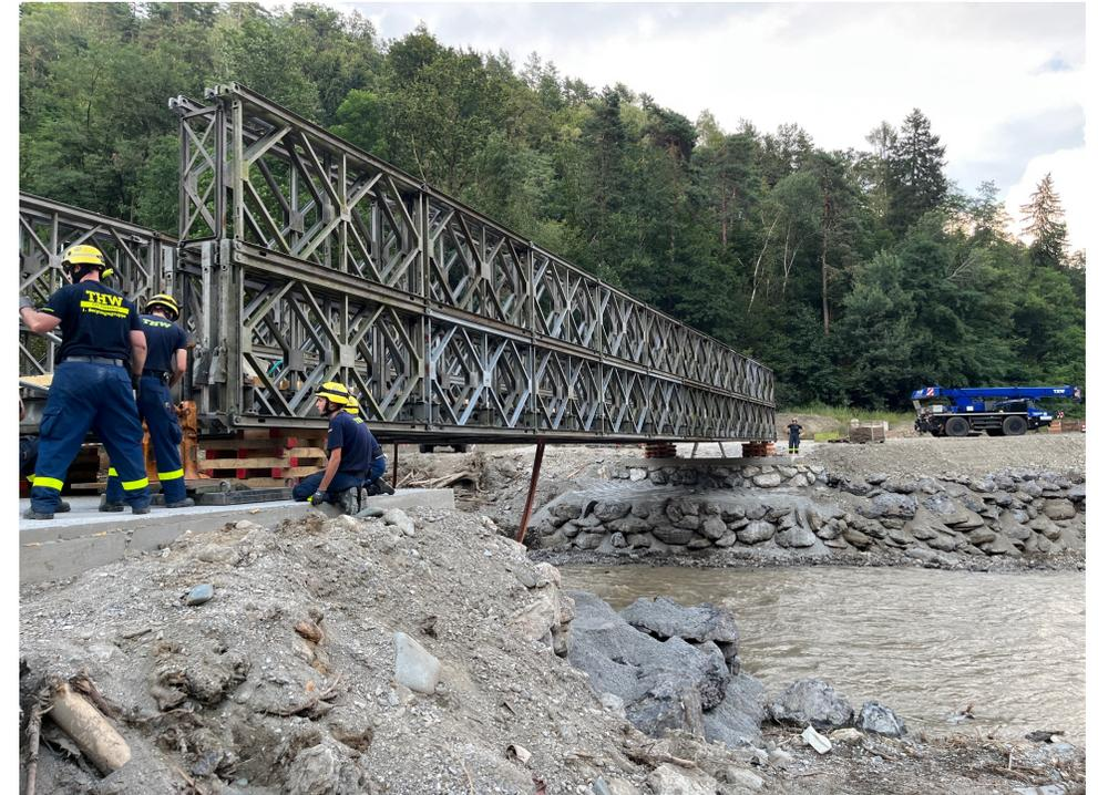
Kraftakt an der zweiten Brücke: Absenken auf die Widerlager um ca. 1,4m mittels manueller Zahnstangenwinden
