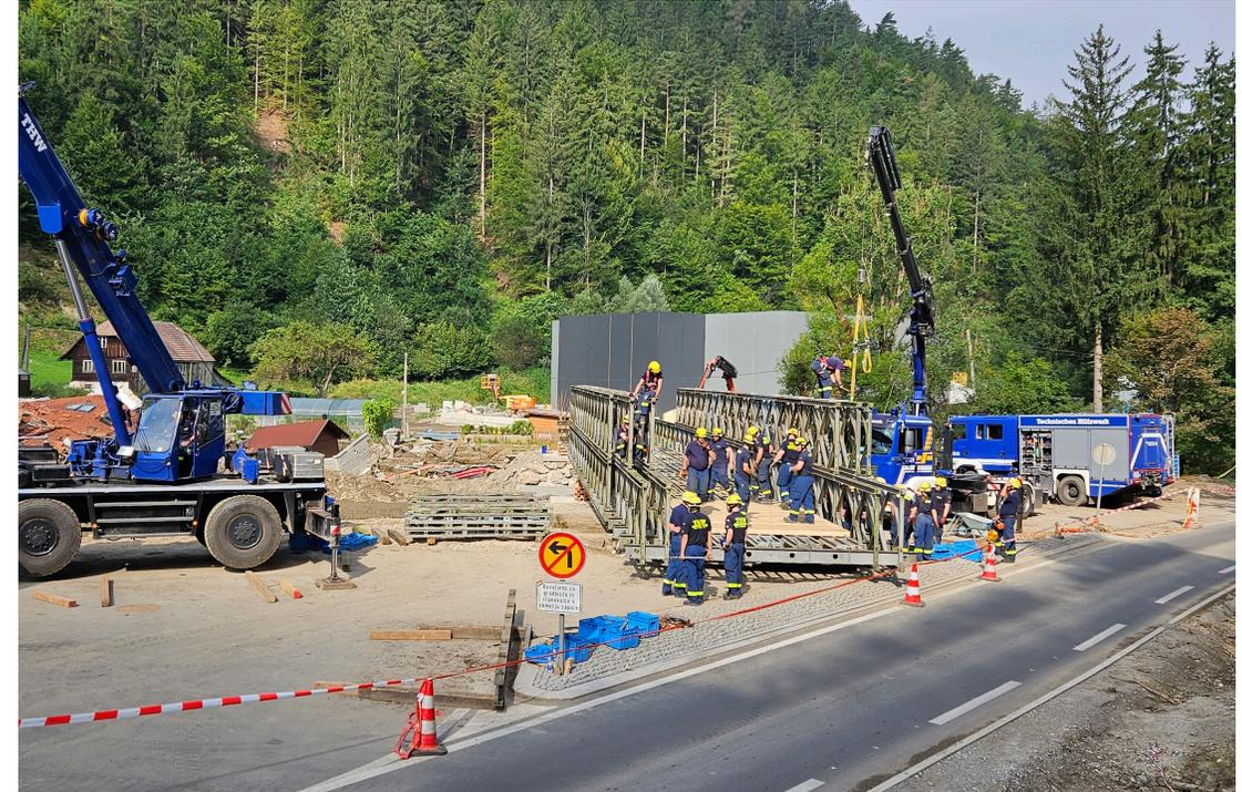
Sehr beengte Platzverhältnisse für die Montage. Nur jeweils ein Feld kann an die Brücke angebaut werden, um die Straße nicht komplett zu blockieren. Parallel zu den Brückenbauarbeiten stellten zwei große Kettenbagger das völlig zerstörte Ufer wieder her.
