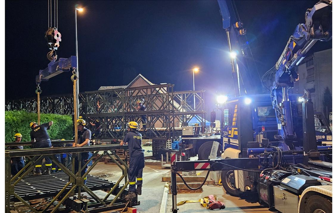
Befestigen eines vormontierten Brückenfelds an der Lastraverse des Krans
