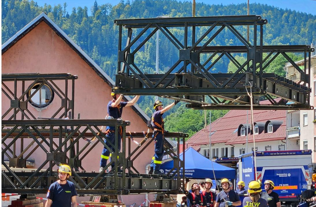
Einheben eines kompletten Brückenfelds zur Montage an der Brücke
