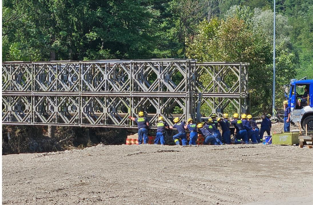
Jetzt gilts, alle Mann ran! Die rd. 50 to. schwere Brücke muss mit Muskelkraft über die Rollenbahn vorgeschoben werden
