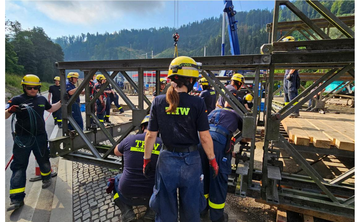
Jeder Handgriff sitzt! Festziehen der Fahrbahnschrauben und legen der Fahrbahnbohlen an der zweiten Brücke
