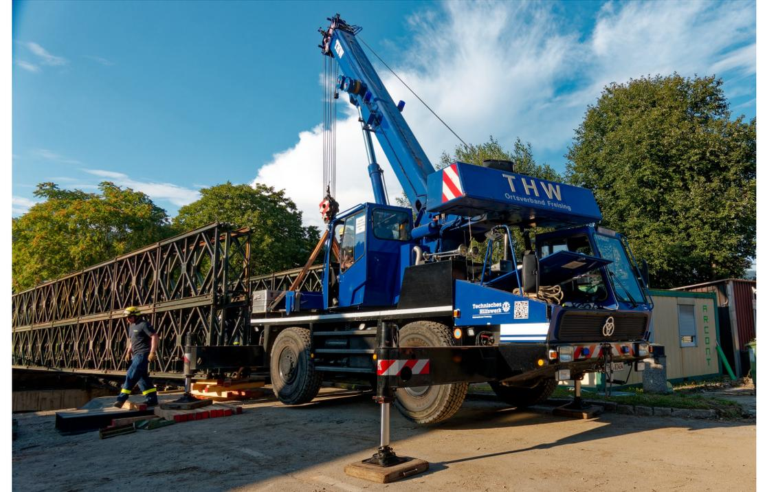
Anheben der Brücke am jenseitigen Ufer mit dem THW-Kran zur Montage der Widerlager
