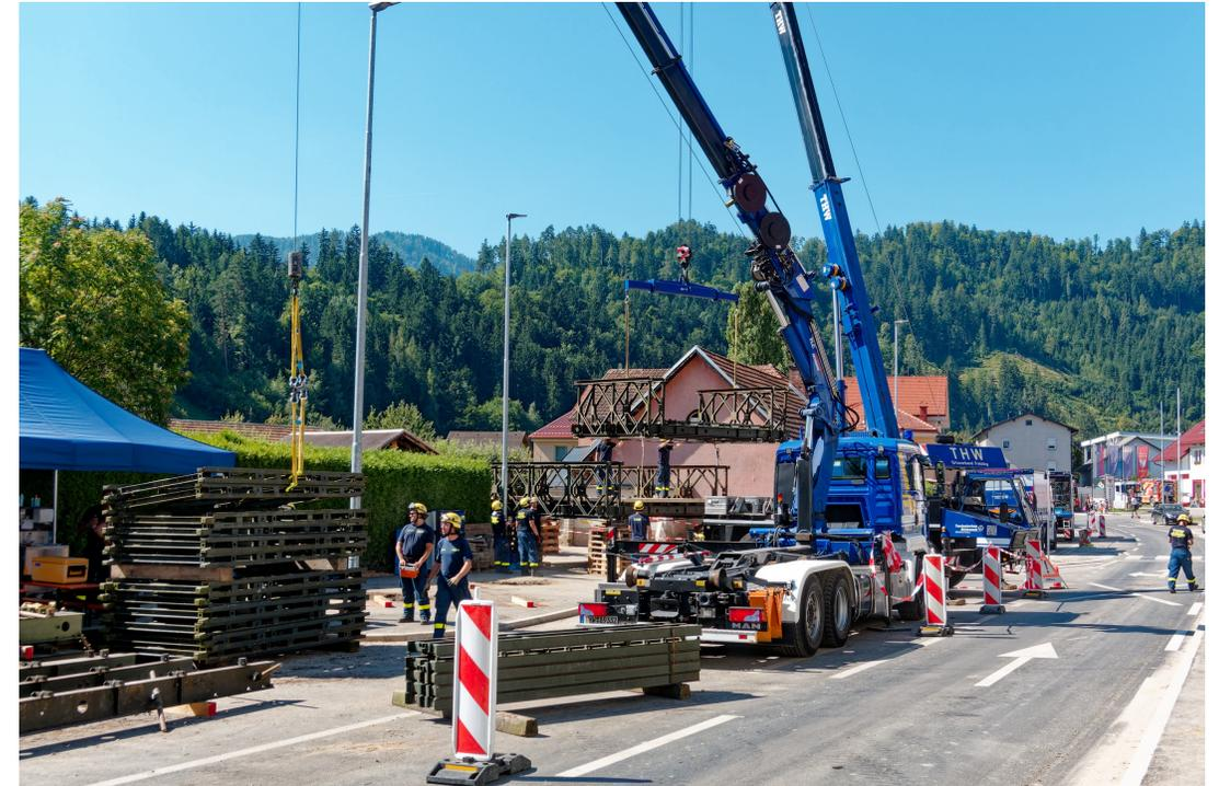
Vormontage der Brückenfelder mit Mobil- und Ladekran und einheben der sog. Querträger (Fahrbahnauflage)
