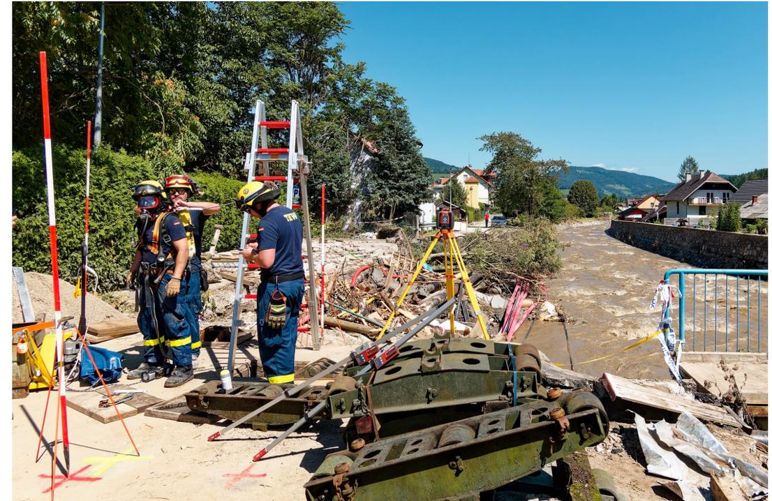
Beginn des Einmessens der Rollenbahn für die Montage und den späteren Vorschub der Brücke
