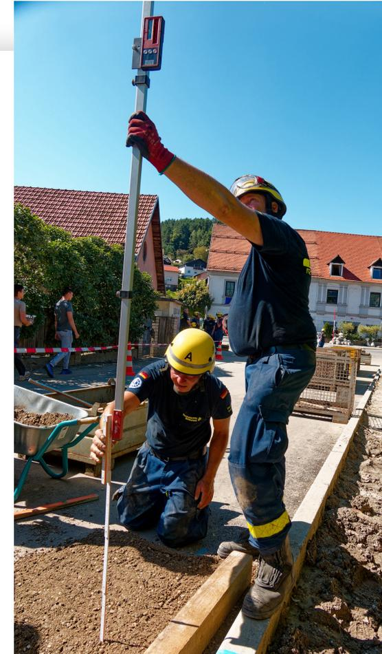
Einmessen der Wiederlager als Auflager für die Rollenbahn (die Brücke darf nur 1° Gefälle aufweisen)
