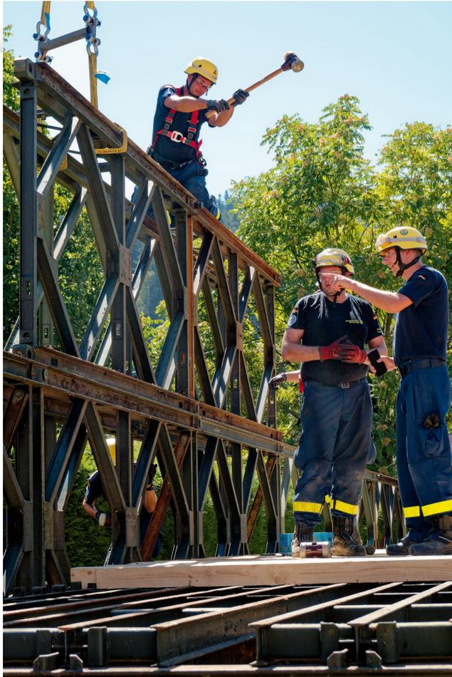
Verbolzen der Doppelwände mittels Schlägel
