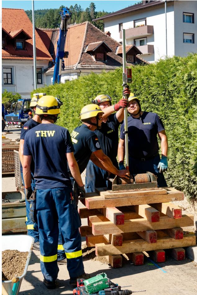
Einmessen der Kreuzholzstapel als Auflager für die Rollenbahn (die Brücke darf nur 1° Gefälle aufweisen)
